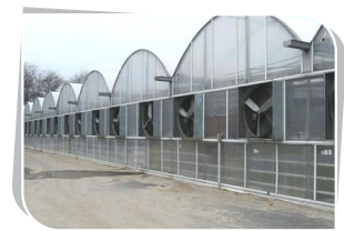
Fan & Pad Poly House
